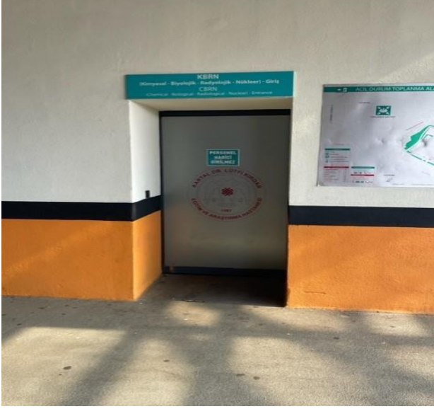
KBRN dekontaminasyon ünitesi girişi
